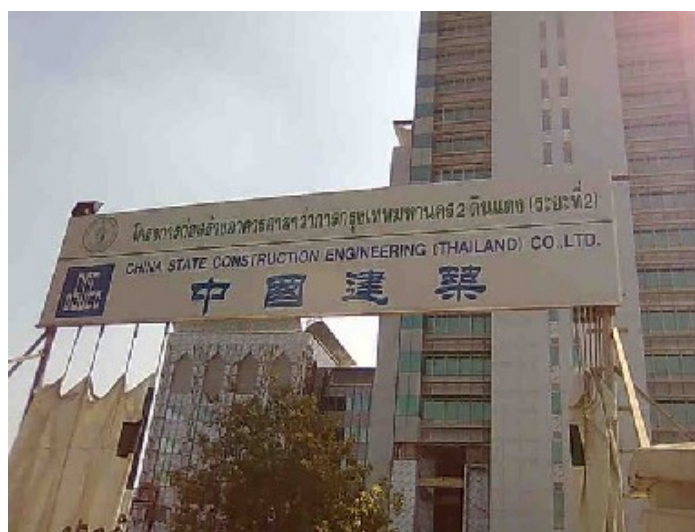
図表2 バンコク都庁第二庁舎（ディンデン地区）第二期建築工事 (筆者撮影：平成21年12月)
