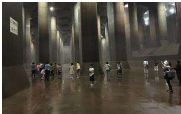
【調圧水槽の内部】
