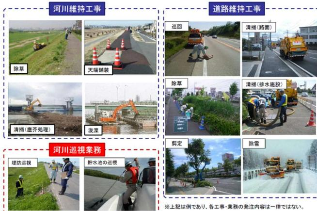
図表 3-1-2 に、維持に係る工事・業務の事例を示す。河川維持工事には、除草、天端舗装、塵芥処理等の清掃、堆砂除却を含む浚渫等があり、河川巡視業務では、堤防巡視、貯水池の巡視等を行っている。道路維持工事には、巡回、路面や排水施設の清掃、除草、樹木の剪定、除雪等がある。
