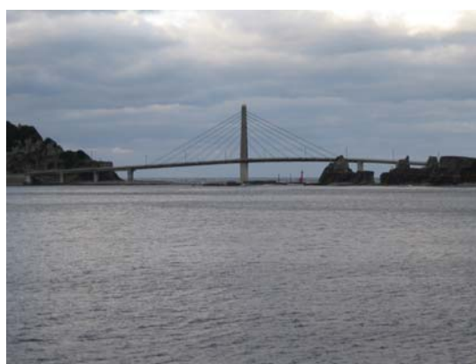
中島と上甌島を結ぶ甌大明神橋
