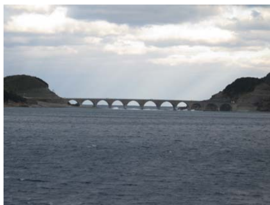
中甌島と中島を結ぶ鹿の子大橋
