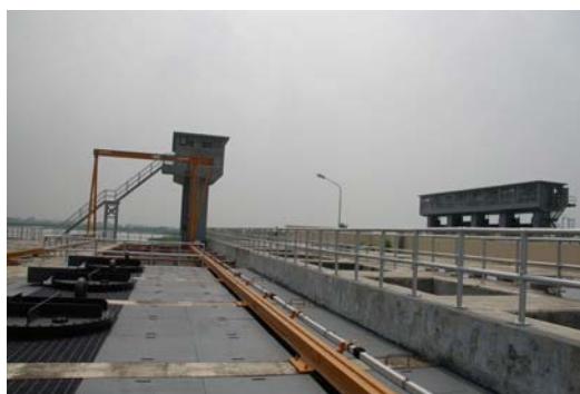
メトロマニラ西マンガハン地区洪水制御事業 （マニラ首都圏内）
