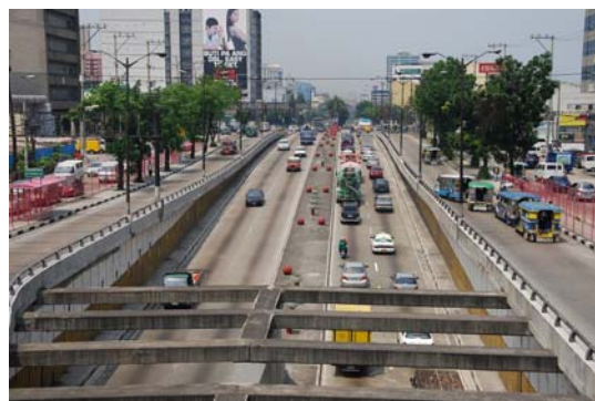
メトロマニラ立体交差建設事業
