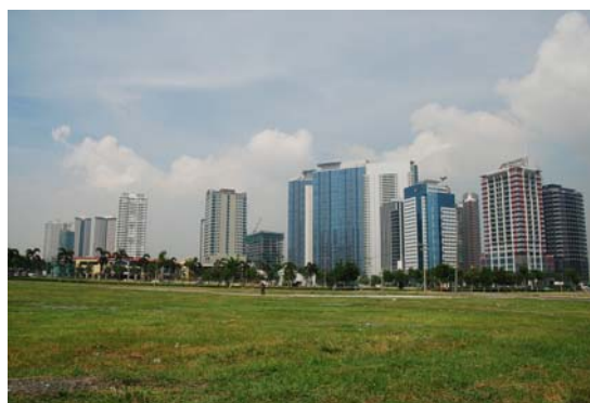
フォートボニファシオ地区において 建設が進む高層住宅及びビル
