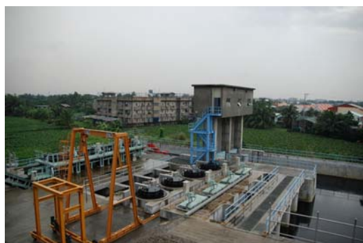
カマナバ地区洪水制御・排水システム改良事業 （マニラ首都圏内）
