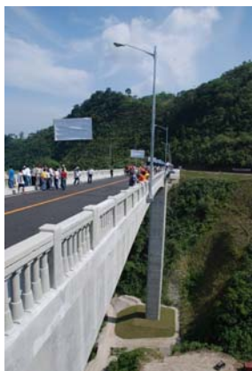
アガスアガス橋（日比友好道路ビサヤ区間） 高さ 75m（フィリピンにおいて最も高い橋）
