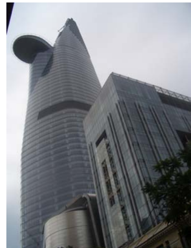
図表 7 ホーチミン市内の 施工中の高層ビル
