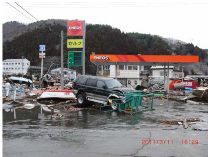
【被災したガソリンスタンド（岩手県建設業協会釜石支部提供）】
