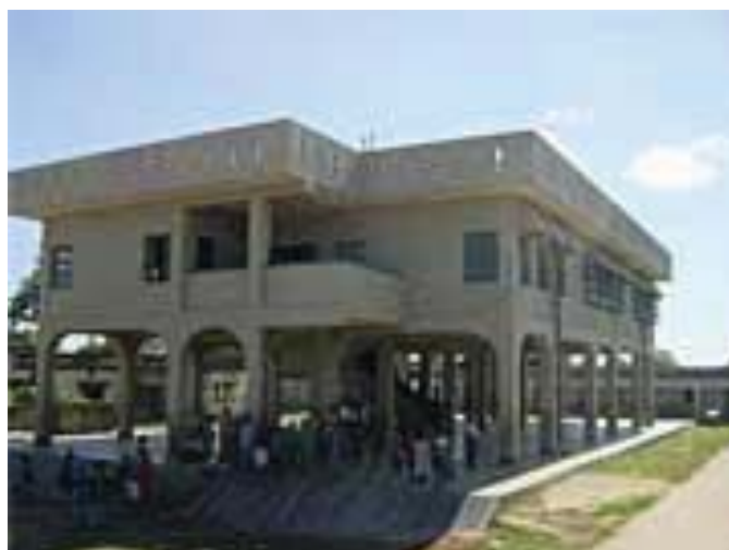
図表 2-2 多目的サイクロンシェルター（平時は小学校として利用）
