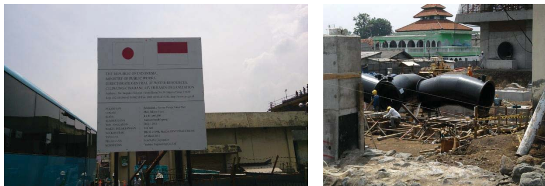
図表 2-7 プルイット排水機場緊急改修プロジェクト②
