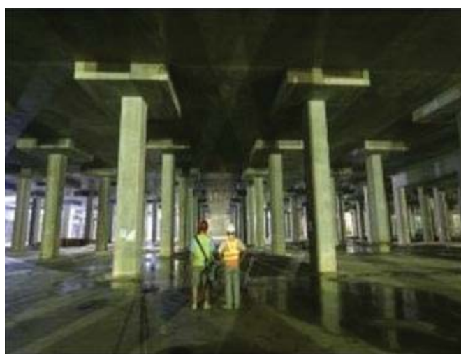
図表2-15 雨水地下トンネル内部
