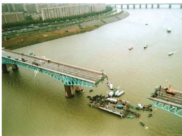
図表2-18 橋梁崩落の様子
