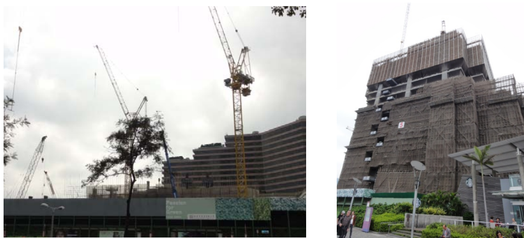
図表5 市街地では数多くのビル建設現場が見られた
