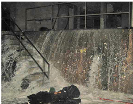
East River Tunnels の浸水状況 (出典) MTA ホームページより
