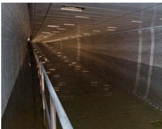
The Hugh L. Carey Tunnel の浸水状況 (出典) MTA ホームページより
