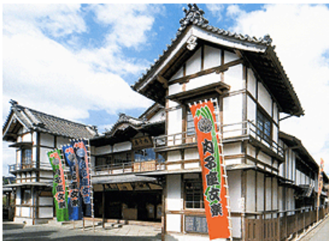
内子座の外観（内子町ホームページ）
