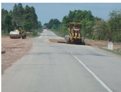
図表 12 道路の補修工事
