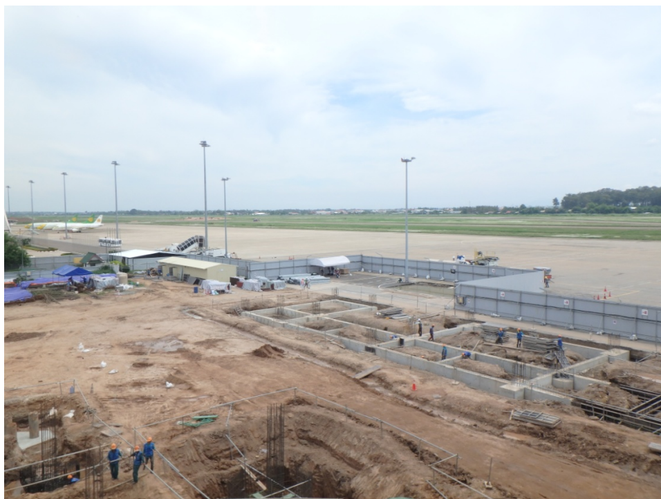
図表 21 空港工事現場
