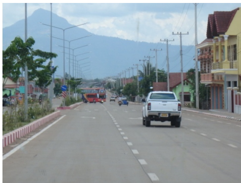
図表 14 パクセの片側 3 車線の道路
