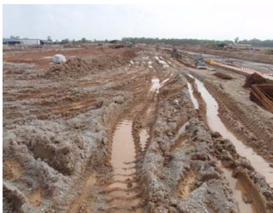
(雨季の施工状況)
