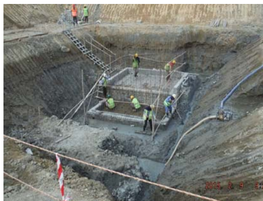
(汚水ポンプ施設)
