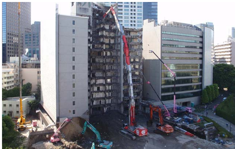
図表 1 解体工事の様子（建築現場）
