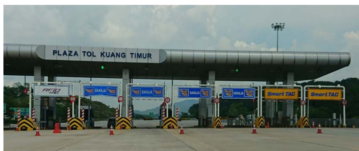
料金所の一例 (左から RFID (白)、Touch'nGO (青)、Smart TAG (黄) の各レーン)
