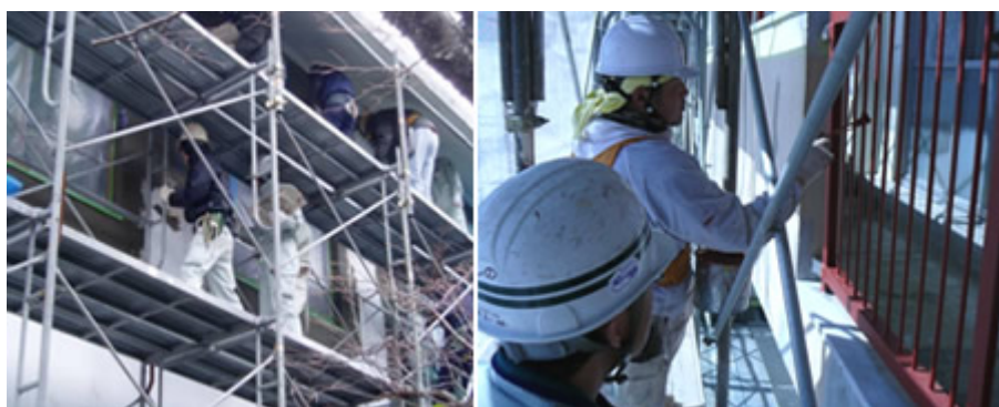
図表 1 塗装工事の様子
