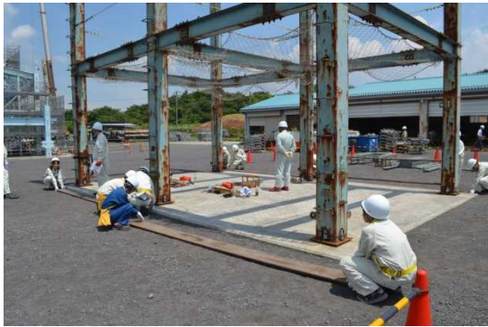
高校生建築基礎技術コースで仮設足場の組立に挑戦
