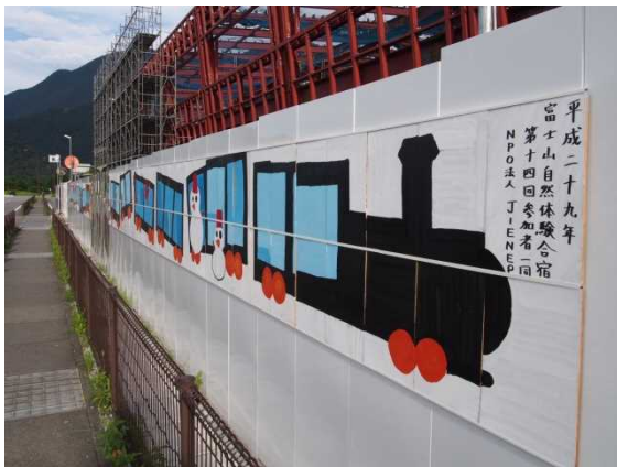
本館・教室棟建替工事の仮囲いに壁画を掲示
