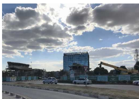
写真 2 ルサカ市内交通渋滞緩和プロジェクト建設現場
