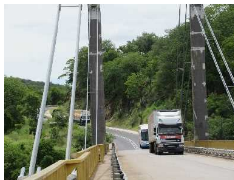
写真3 橋を通行する車両と通行待ちの車両
