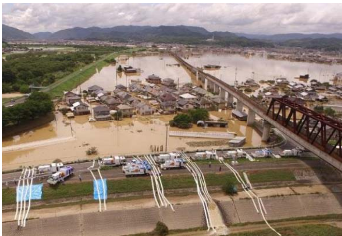
図表 3 真備町での排水作業の様子（平成 30 年 7 月豪雨）
