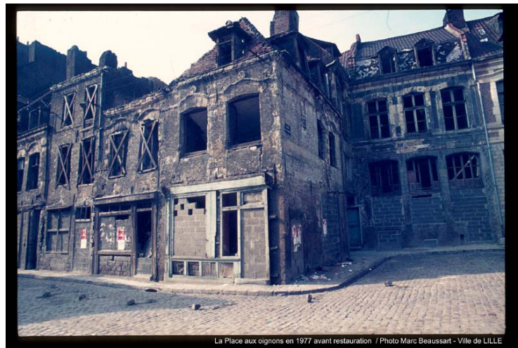
図表 3-1-4 老朽化して放置された建物群 (70 年代)
