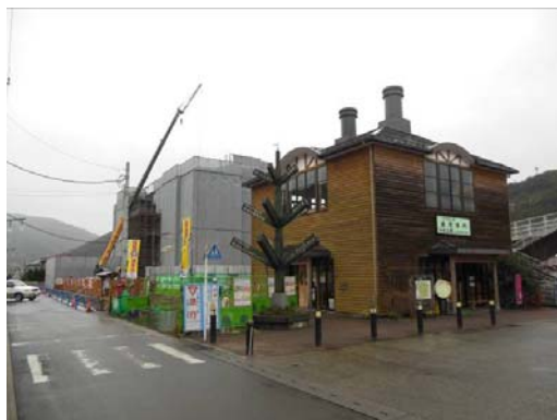
建設中現場（左奥）
