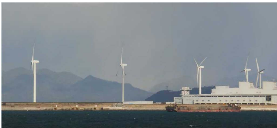
図表 1-5-12 響灘風力発電所
