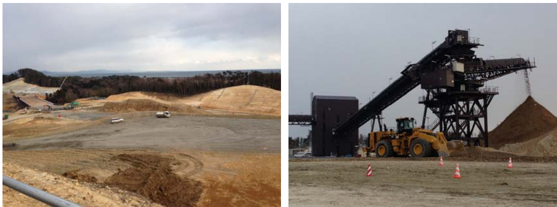
図表 2-1-16 東松島市野蒜北部丘陵地区工事の様子 (2014 年 1 月 16 日)
