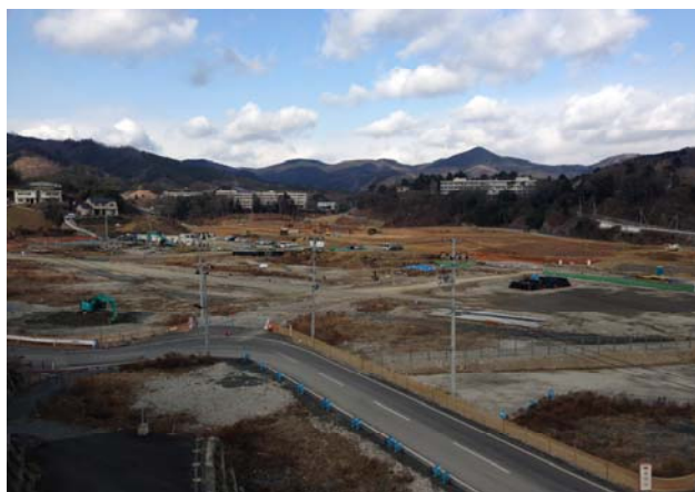
図表 2-1-15 女川浜駅周辺工区における盛土工事の様子（2014 年 1 月 16 日）
