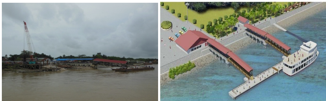
図 4-1-27 ダラ地区フェリー桟橋改修工事の状況と完成予想図
