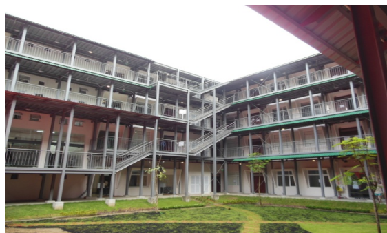
図表 4-1-25 改修されたミャンマー旧建設省
