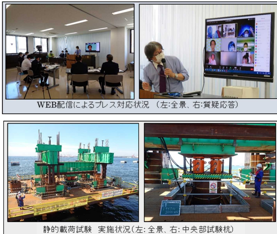
図表 3-2-31 大阪湾岸道路西伸部 鉛直載荷試験状況
