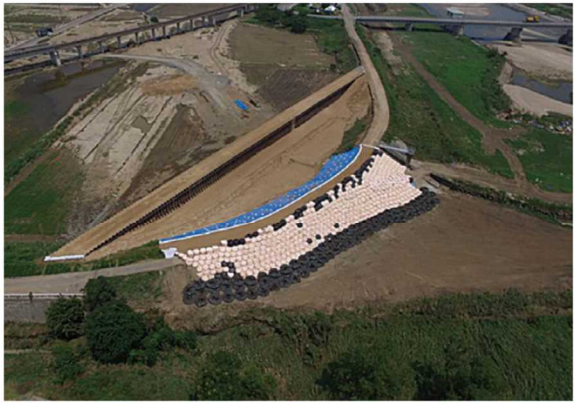
応急復旧堤防完成状況【7月19日撮影】
