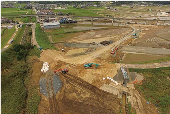
荒締切盛土施工状況【7月13日撮影】
