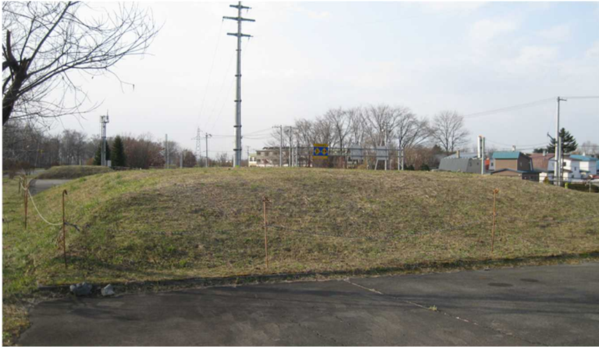
図表 5-2-6 帯広防災ステーションにおける備蓄土砂
