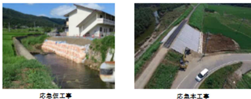
図表 2-1-4 応急工事の事例
