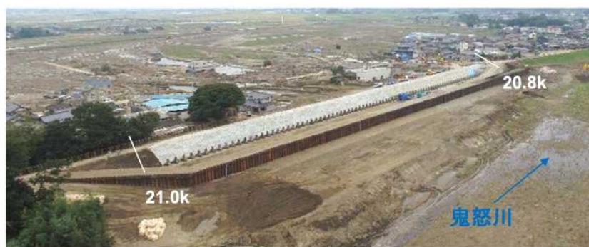
応急復旧状況(9/24)
