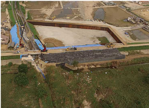
応急復旧堤防完成状況【7月21日撮影】
