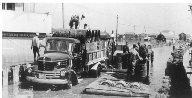
図表 5-1-1 伊勢湾台風復旧に採用されたドラム缶工法
