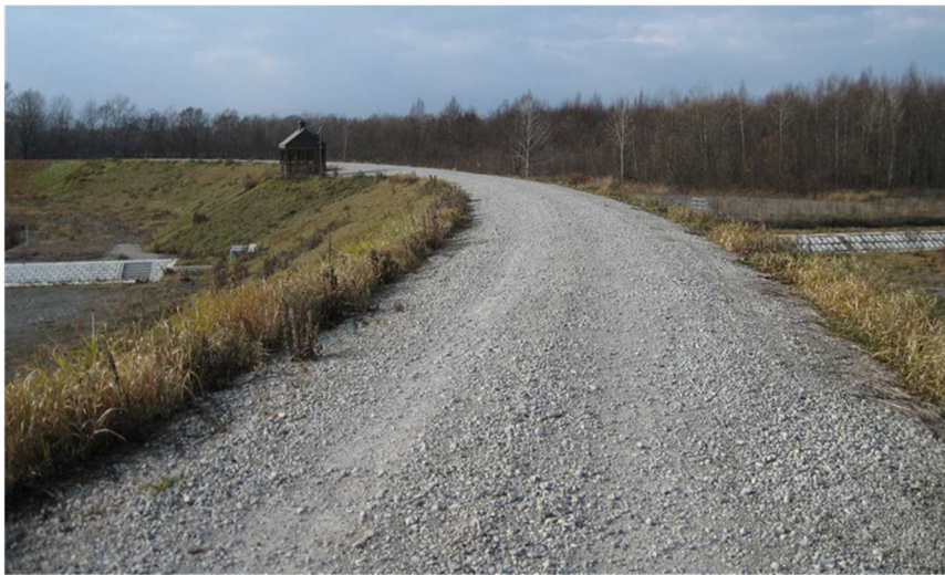
図表 5-2-2 復旧後の札内川 KP25.0 堤防
