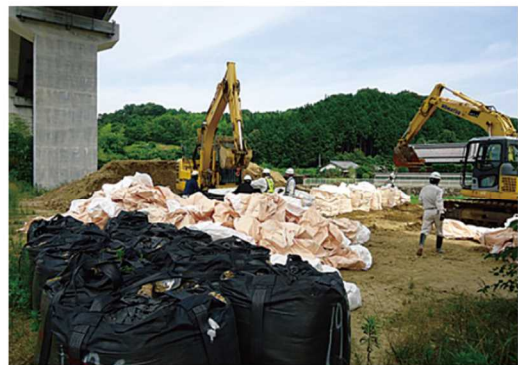
大型土のう製作支援状況【7月13日撮影】
