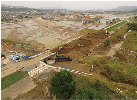
荒締切施工状況【7月12日撮影】
