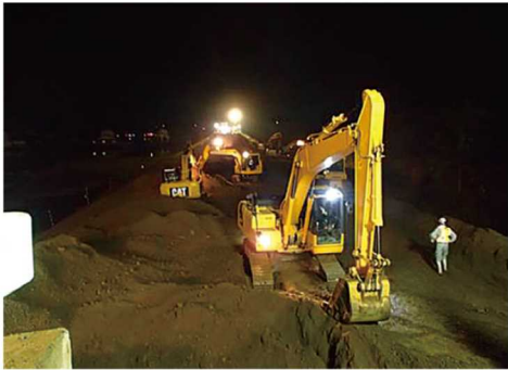
荒締切盛土夜間施工状況【7月13日撮影】
