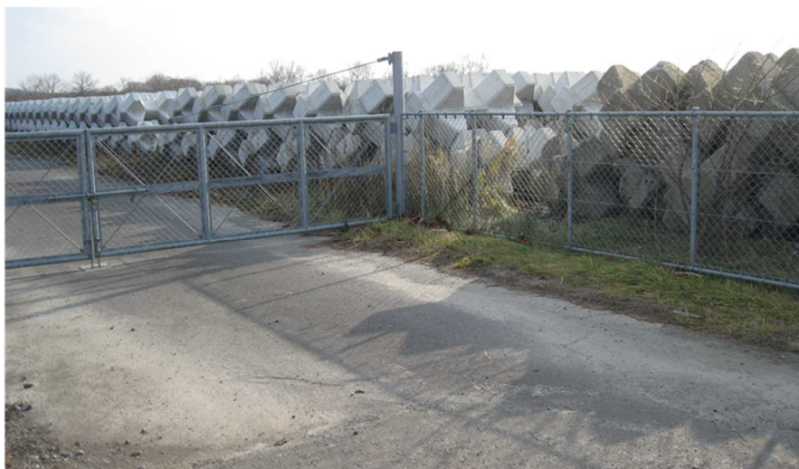
図表 5-2-3 下士幌水防拠点におけるブロック備蓄状況
