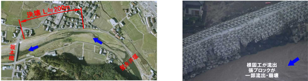
図表 2-2-2 花月川応急復旧箇所の再度被災状況
