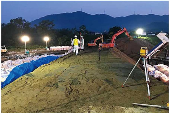
荒締切盛土施工状況【7月14日撮影】
