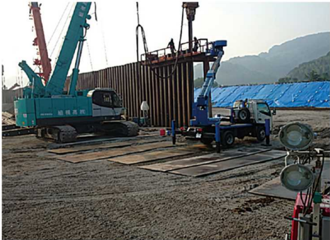
鋼矢板二重締切堤施工状況【7月18日撮影】
