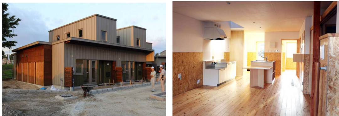
図表 6 建設中の復興住宅
