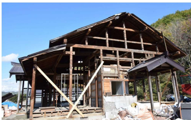
図表 5 古民家の移築作業の様子
