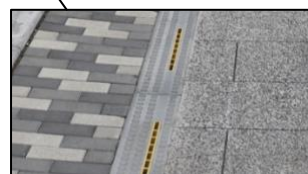
<写真：美装化舗装した道路>
