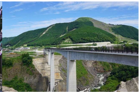
【写真 45】熊本地震の被害を乗り越え、インフラ関係はここ 2 年で劇的に創造的復興を遂げています
