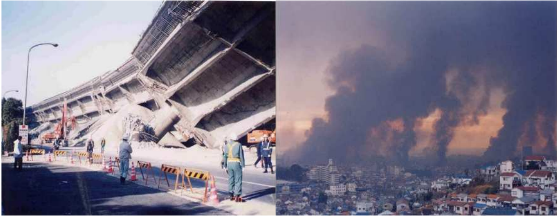
【左】倒壊した阪神高速道路、【右】長田方面の火災（人と防災未来センター資料室保存資料より）
