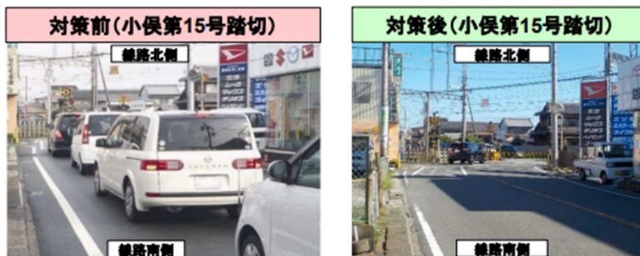
図表 9 小俣第 15 号踏切 対策前（左）と対策後（右）
