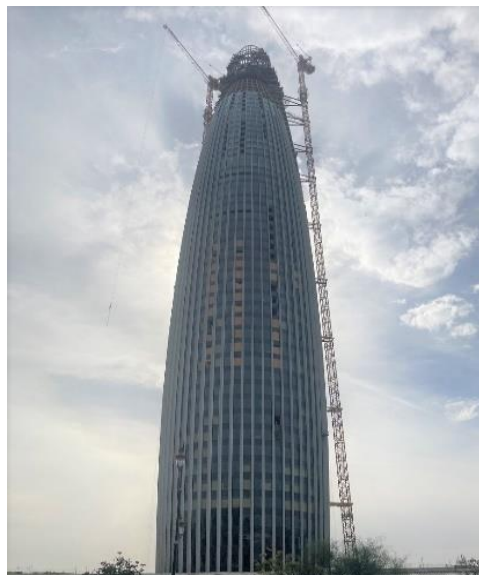
モハメド6世タワー（施工中）
