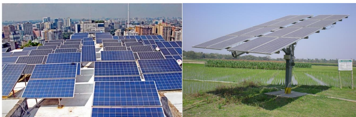
図表9 バングラデシュにおける太陽光発電事例 (左：集合住宅屋上ソーラーパネル、右：ソーラー灌漑ポンプ)
