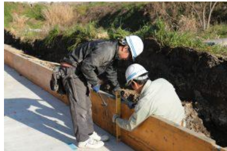
実際の工事現場での実習状況
