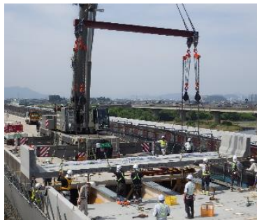
写真7：橋梁床版取替
