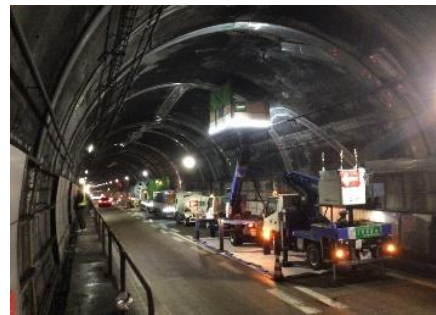
写真8：トンネル覆工補強
