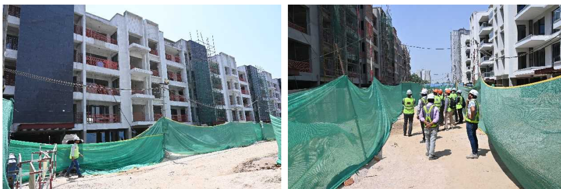
住宅エリアの建設現場
