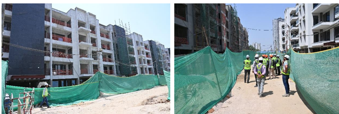
住宅エリアの建設現場
