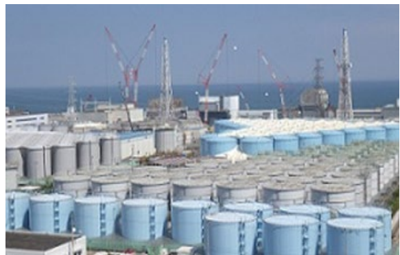
多核種除去設備（ALPS）等処理水タンク
