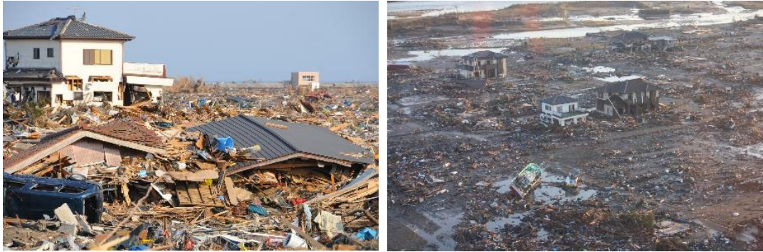
東日本大震災・津波被害（浪江町）
