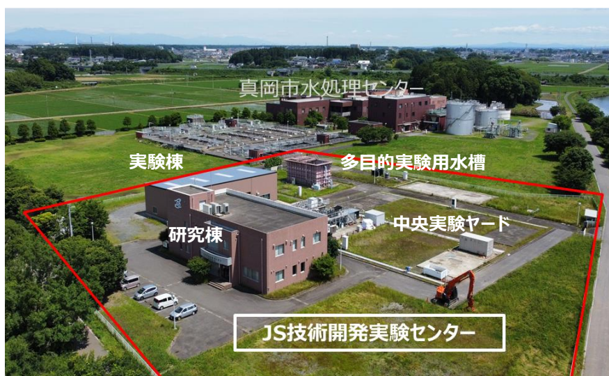
技術開発実験センター全景（栃木県真岡市）
