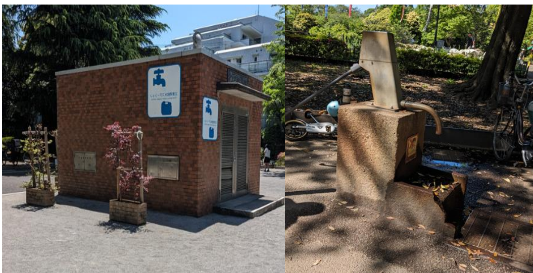
写真 3 及び 4 災害時用の給水ステーション（左）及び井戸（右）
