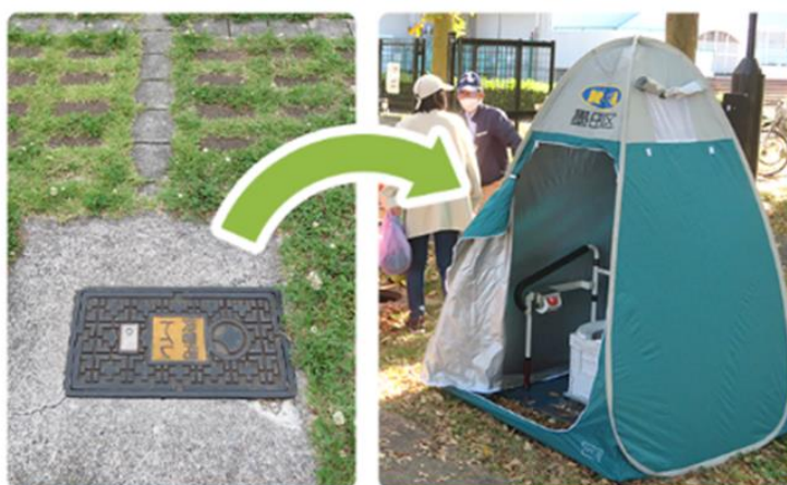
図表5 マンホール型の災害用トイレ
