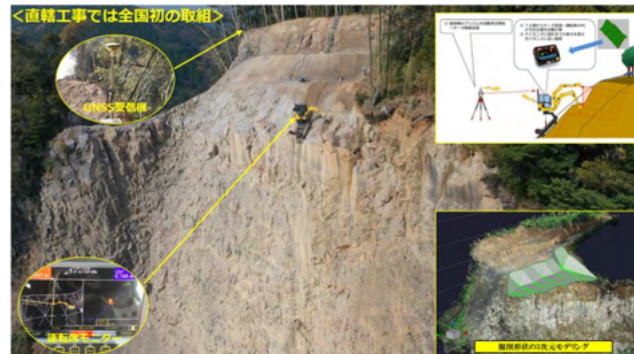
図表 18 急斜面法面掘削機による ICT 施工
