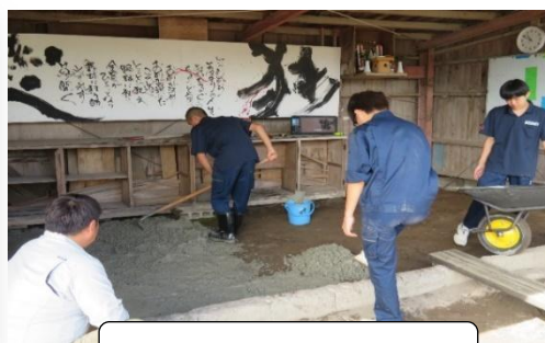
施工実習（コンクリート打設）
