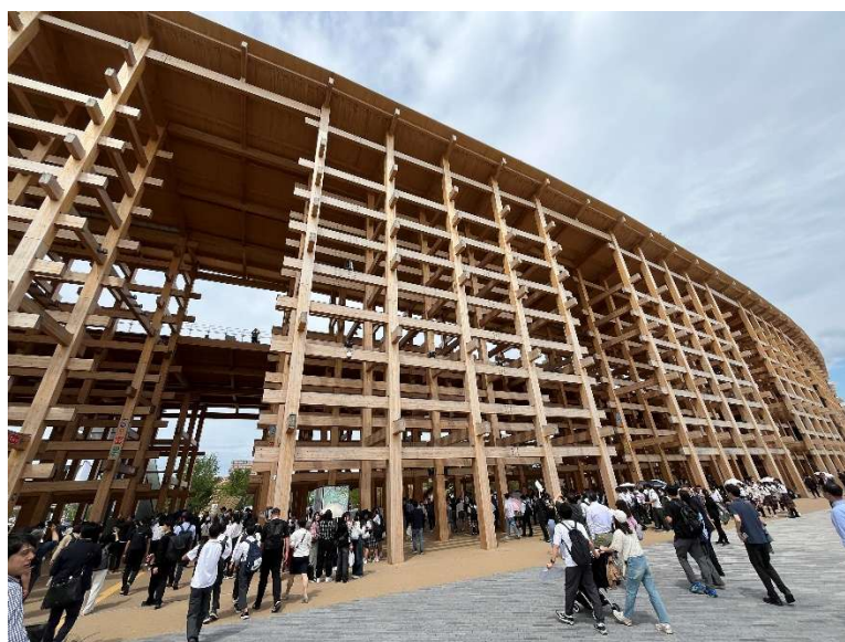
東口広場の大屋根リング
