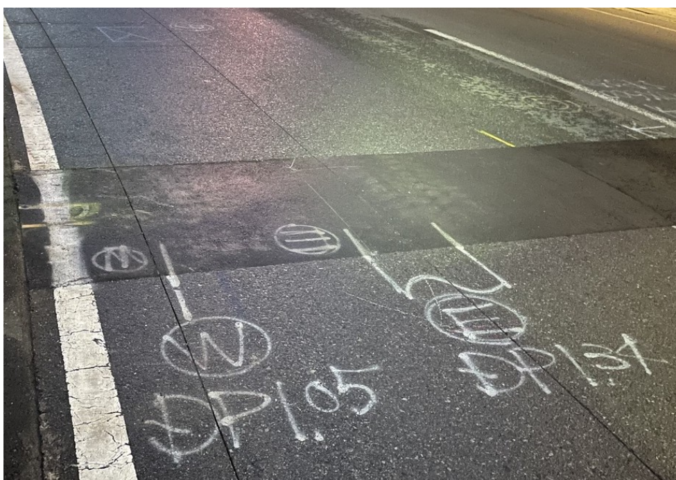
図表7 マーキングによる埋設管の位置と深さの明示状況
