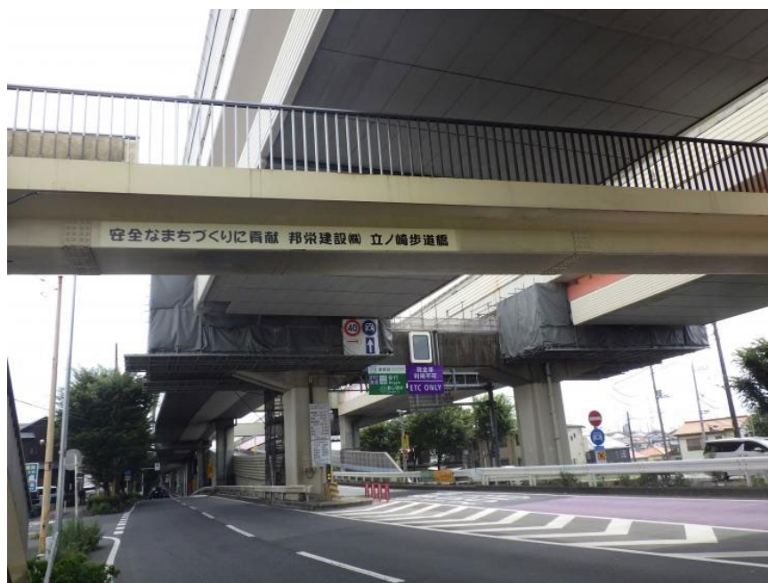
(写真) 立ノ崎歩道橋／埼玉県 HP より
