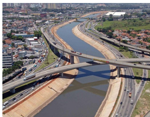
図7 河川改修後のチエテ川 出典：JICA WEB サイト 7)
