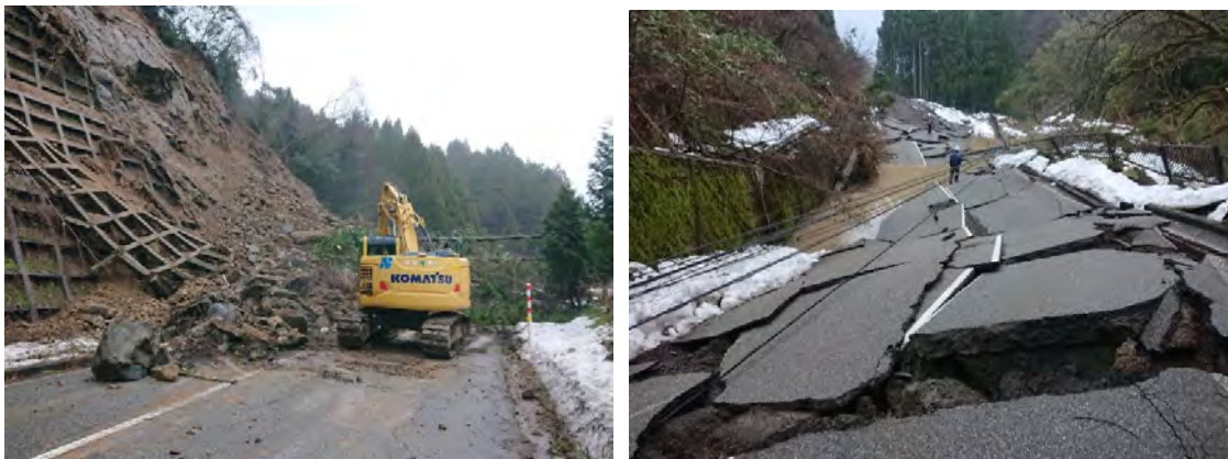
図表9 土砂崩れ（左）、国道249号の甚大な被害（右）
