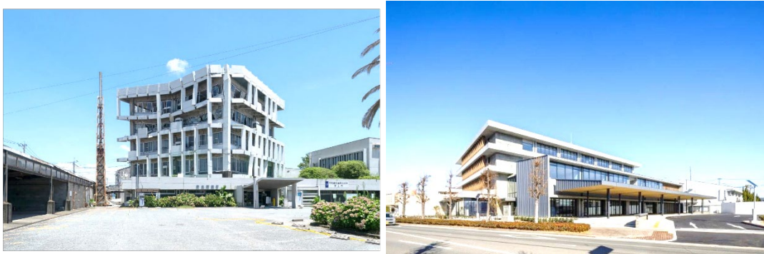
図表 1 被災した宇土市旧庁舎（左）と新庁舎（右）
